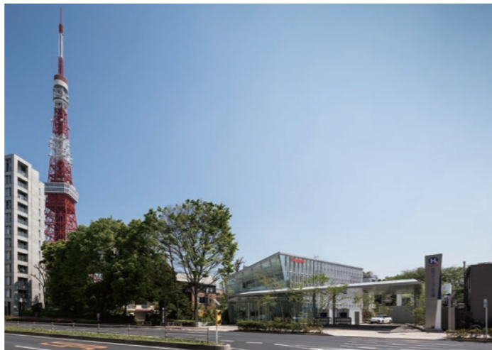
フラッグシップとして建設されたイワタニ水素ステーション芝公園
