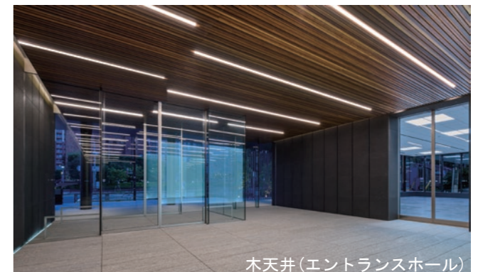
木天井(エントランスホール)
