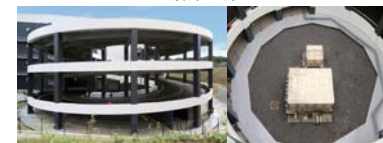
PC造ランプウェイ 受水槽(上)井水槽(下)
