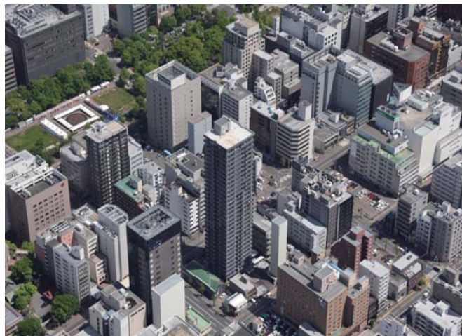
南西側俯瞰（北側の緑地は大通公園）
