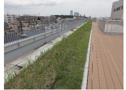
ススキ・チガヤなどの屋上緑化
