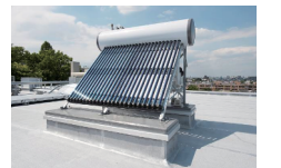
太陽光給湯システム
