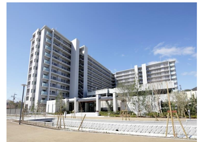
緑視率向上を図った沿道緑化と駐車場棟の壁面緑化
