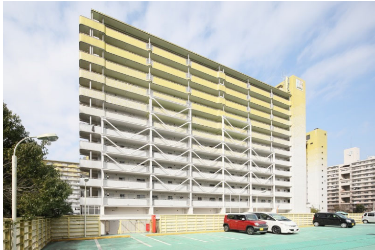
写真 補強建物外観
