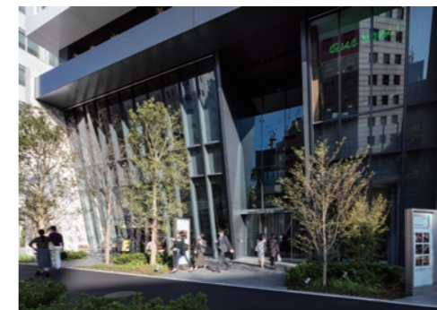
日比谷通り側 エントランス
