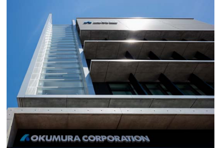
奥行のある庇とルーバー
