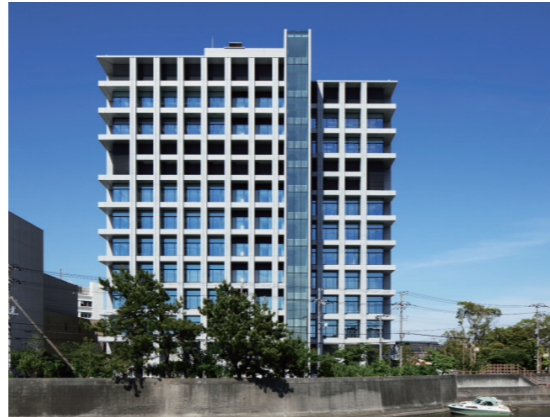
PCによるアウトフレームで構成された外観
