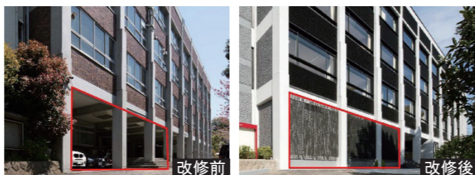
改修前 改修後 ピロティの屋内化でカフェテリアを新設
