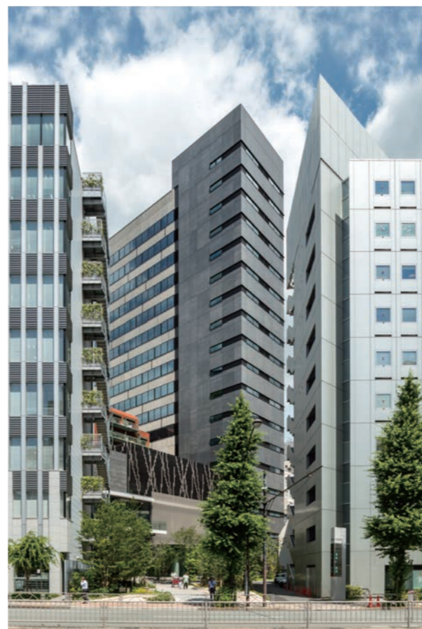
東側外観. セットバックして、緑豊かな外構を設置
