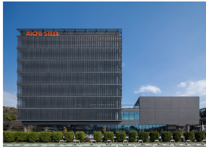
西面外観（左：事務所棟、右：ホール棟）
