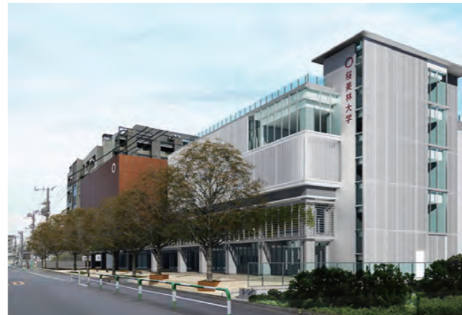
前面道路からみる建物ファサード
