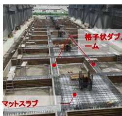
格子状ダブルビーム施工状況
