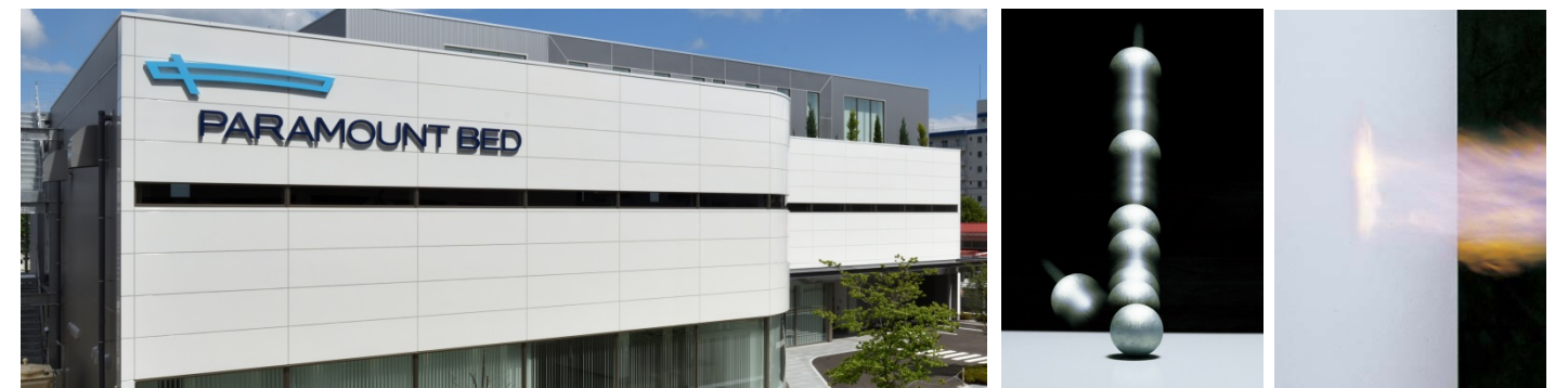
西側ホーローパネル外壁
