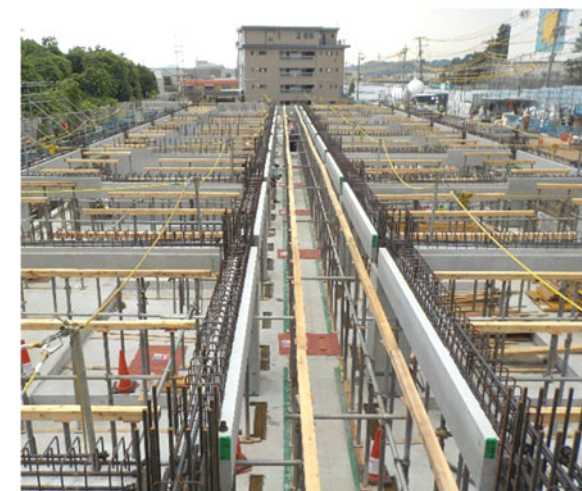
2階梁建て方完了状況
