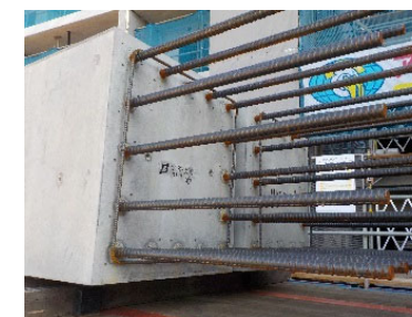
Pca柱部材搬入状況
