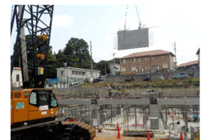
Pca建て方状況
