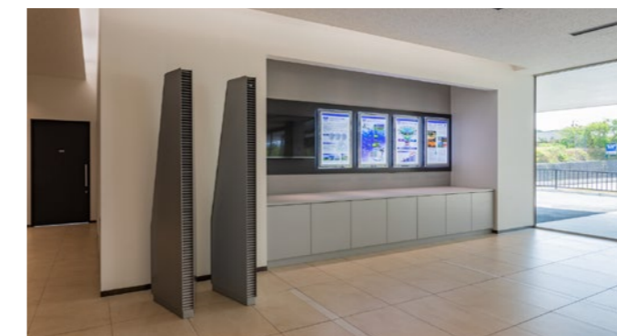
エントランスホール（クールチューブの吹き出し口）
