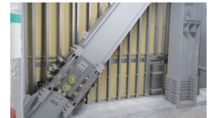
制震部材（ブレーキダンパー）
