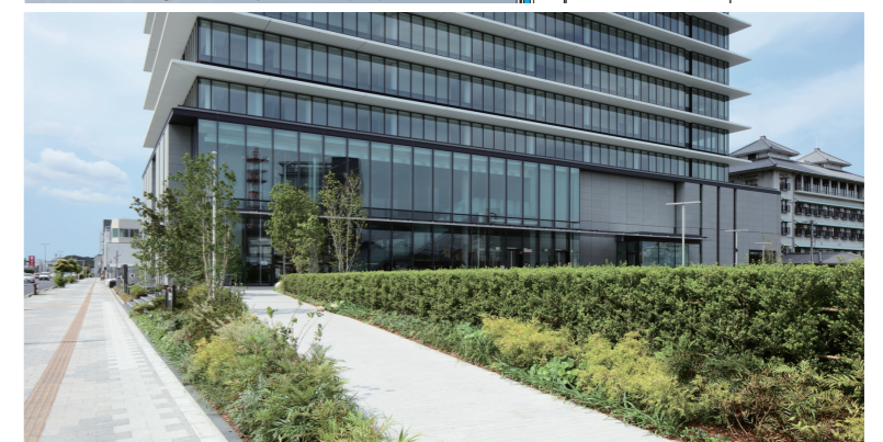
歩道と一体的に計画された開放的な外構。津波シミュレーションや河川氾濫を考慮し、周辺地盤より1mほど建物レベルを上げている
