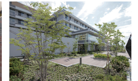
循環型屋上緑化システム採用の屋上緑化
