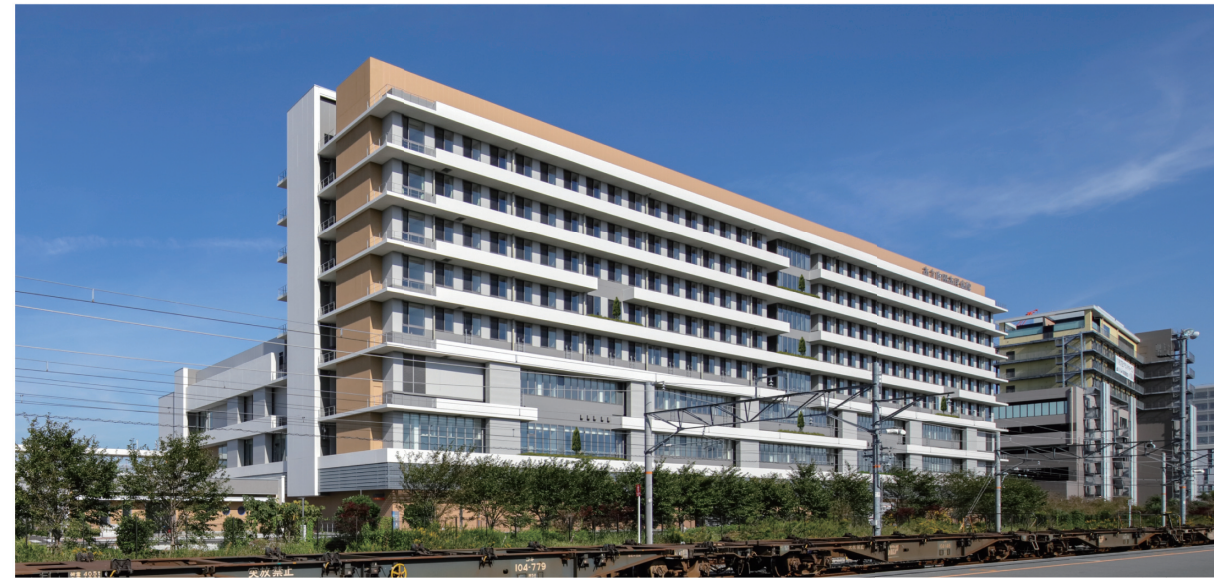
南側外観：日射抑制機能を持たせたバルコニーが織りなす水平基調の伸びやかなデザイン
