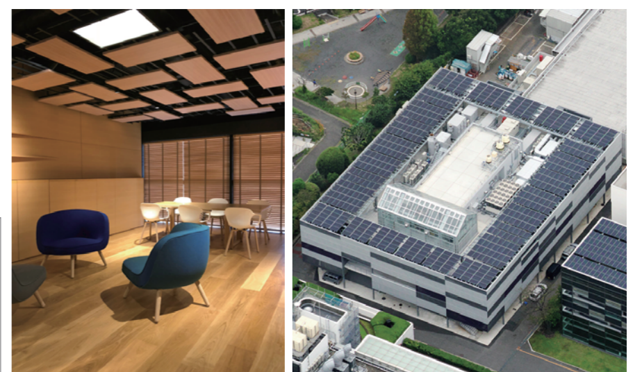
薄型ダクト (H100mm) 採光装置 高効率な単結晶シリコン太陽電池モジュール
