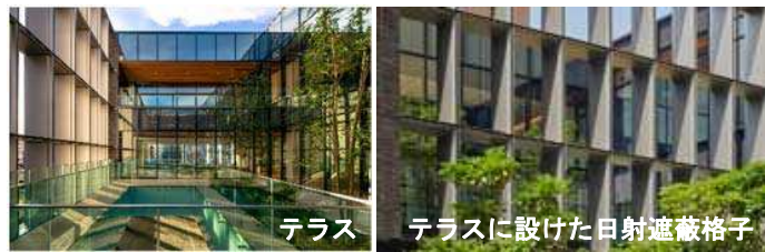
高性能パッシブファザードを用いた西側外観
