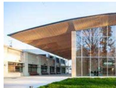
エントランス棟：LVL折板構造
