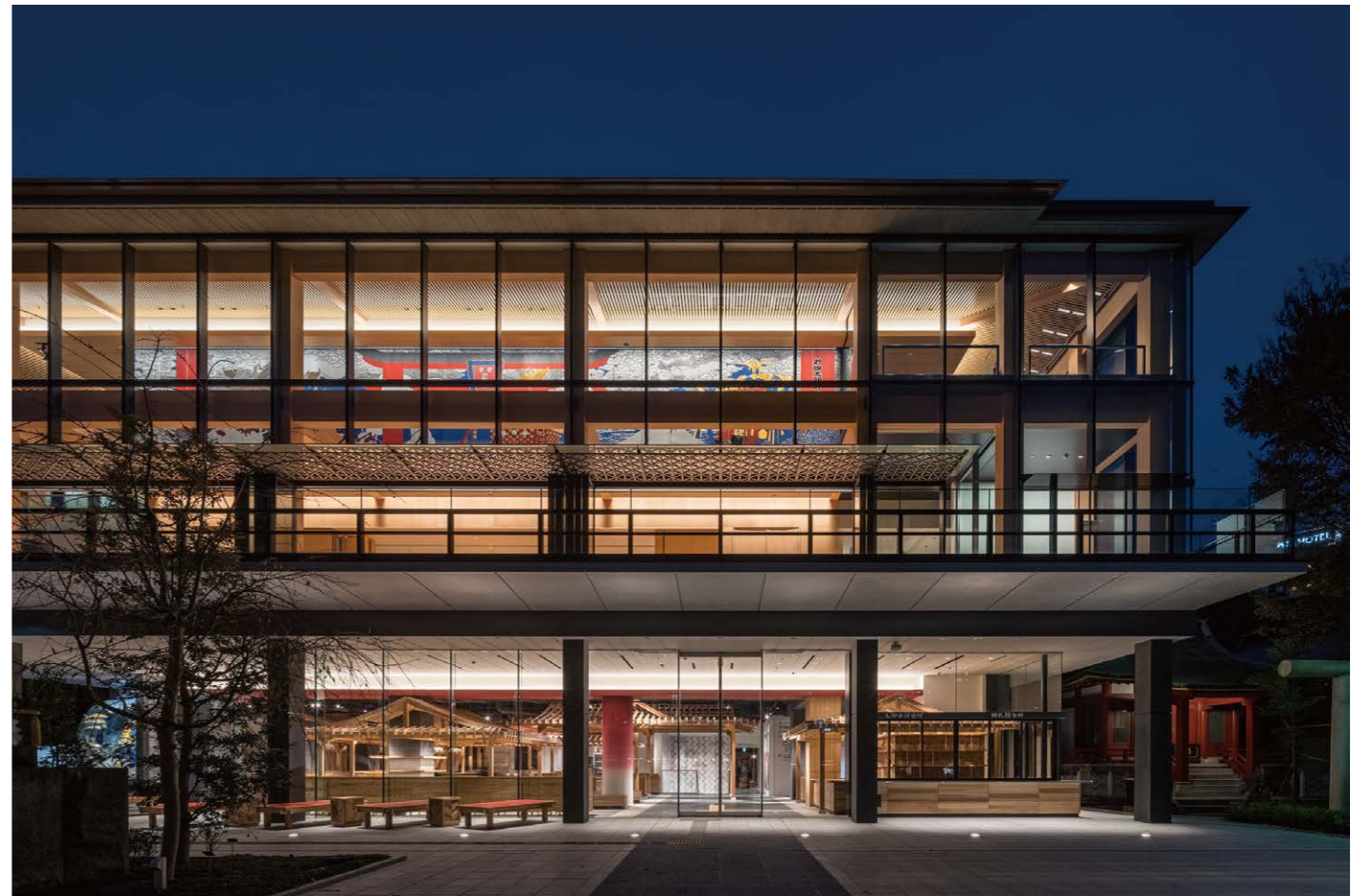
木造・木質化された空間が境内へと開き、境内が入り込む
