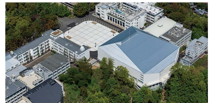
屋根頂部の換気窓
