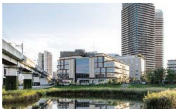
アクアテラス（柏の葉2号調整池）からの外観
