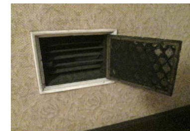
既存制気口(旧寝室)
