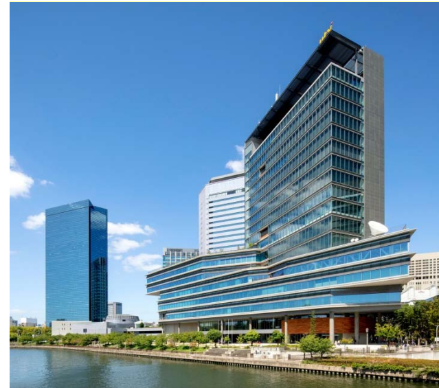
南面外観写真（手前が第二寝屋川）
