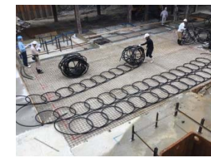
地中熱コイル敷設状況
