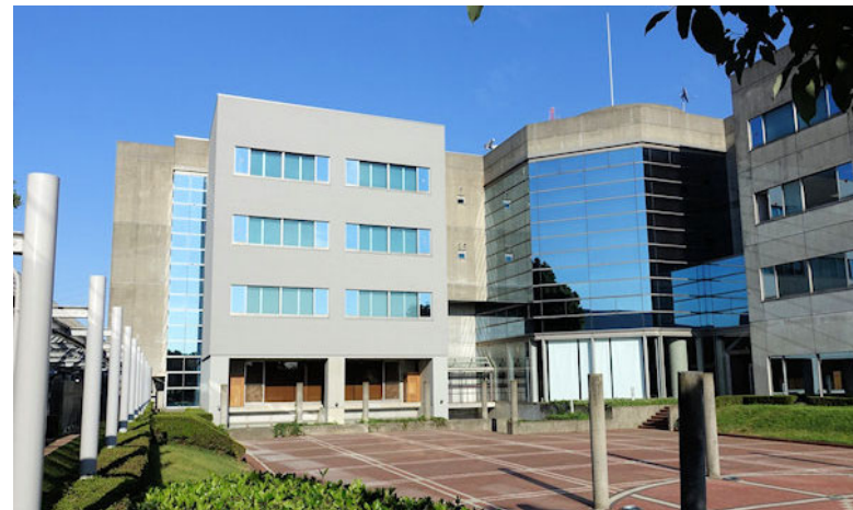
写真1 対象建物外観（写真左が改修対象）
