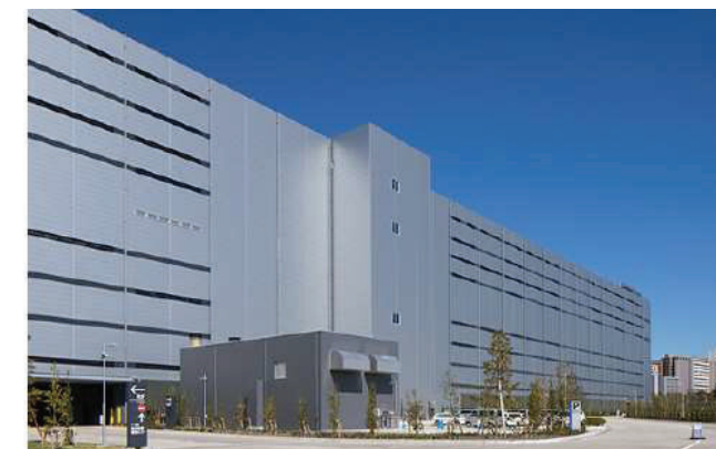
非常用発電機棟
