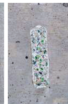
既存壁補修②
