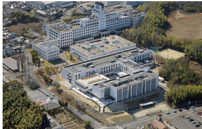
鳥瞰写真（手前が新8号館）
