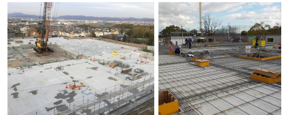
1階床施工中写真
