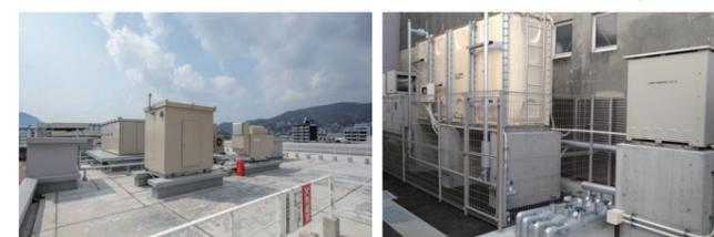
屋上に設置した保安用途利用の自家発電機(左) 建物1階床と同じ高さに設置した受水槽(右)
