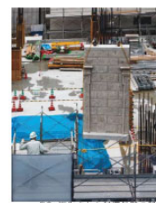
PC板化された被爆外壁の設置
