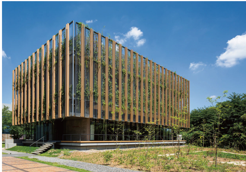
南側外観・ビオトープ
