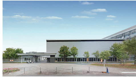
旧正門（改修前）
