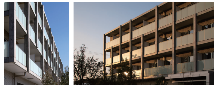
外観詳細（南面）
