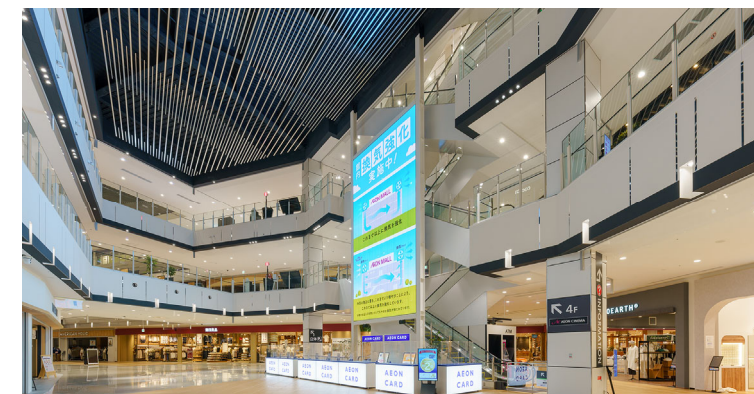
センターコート（2kg/㎡以下のルーバー天井、災害時の緊急避難放送も可能な大型LEDサイネージ）
