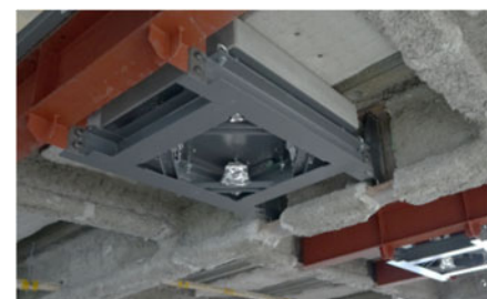
写真8 制振装置TMD
