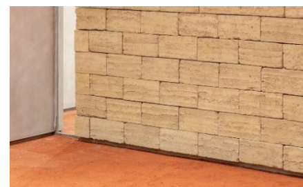
写真10 現場の土を利用した『還土ブロック』
