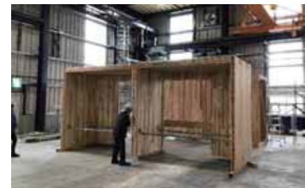
CLTユニットの工場加工状況
