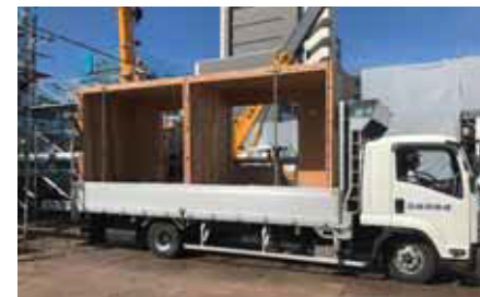
CLTユニット運搬状況
