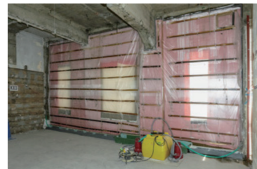
再アルカリ化工事
