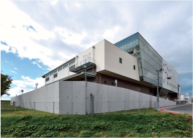
建物北東面外観
