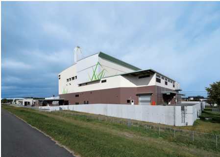
建物南東面外観
