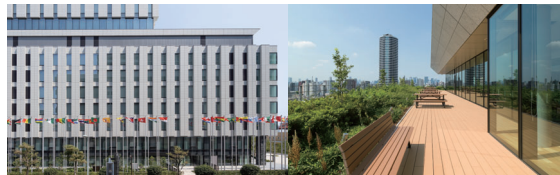
外装により開口部は影ができる
