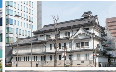
計画前の御堂筋側外観***
