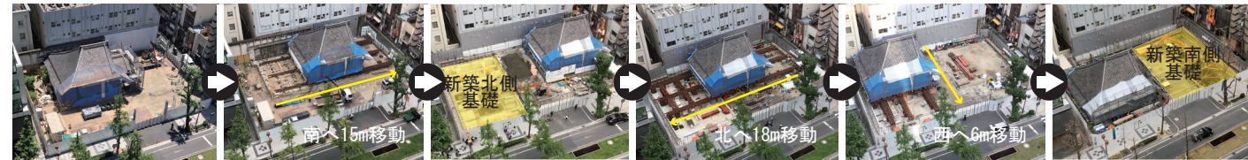
①解体後(本堂だけを残し旧庫裡は解体) ②曳家1回目(北→南へ15m移動) ③新築基礎工事(敷地北側の本体建屋の杭、基礎を施工) ④曳家2回目(南→北へ18m移動) ⑤曳家3回目(東→西へ6m移動) ⑥新築基礎工事(敷地南側の本体建屋の杭、基礎を施工)
