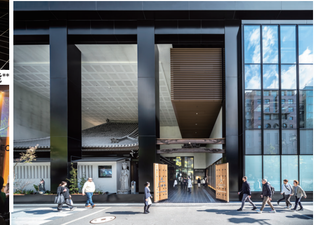
3層吹抜けピロティに本堂が建つ**
