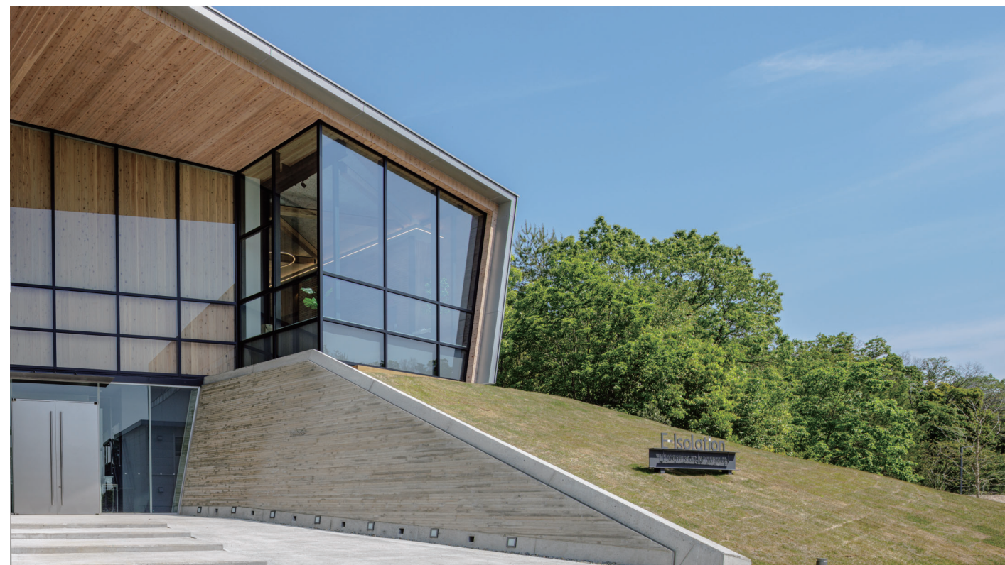
掘削土を再利用した丘の上に浮かぶボリューム
