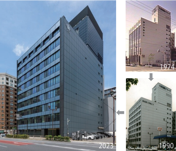
築年数が経過した事務所ビルが建ち並ぶエリアにおいて、既存ストック積極的な活用モデルケースとなり、「まちの歴史」を継承する
