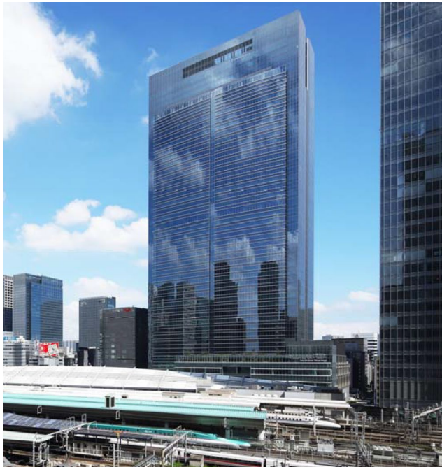
外観（東京駅側から）
