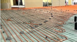
床輻射空調(施工中)
